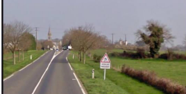
Vue 4 : Depuis la RD 219 à l'entrée du bourg
